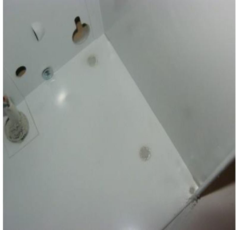
Kitchen exhaust fan
