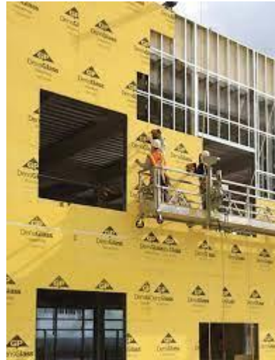
Steel Stud / Exterior Sheathing
