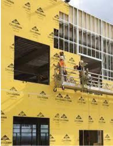
Steel Stud / Exterior Sheathing
