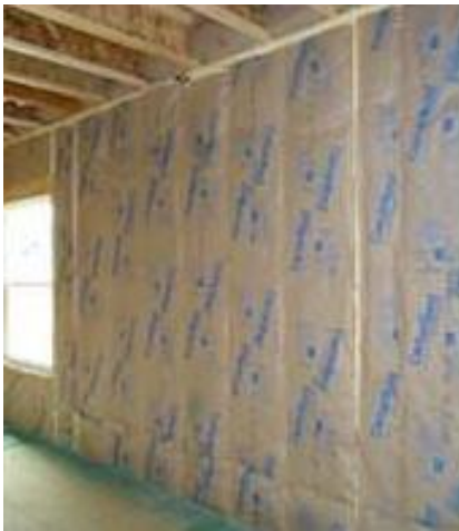
Grade I: Compliant
