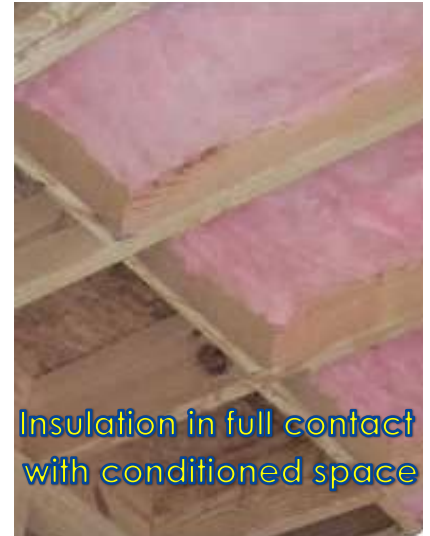
Grade I: Compliant
