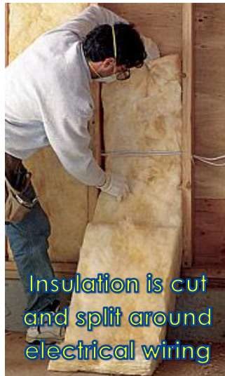
Grade I: Compliant
