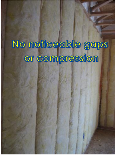
Grade I: Compliant
